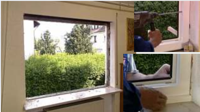
Vor der Montage
