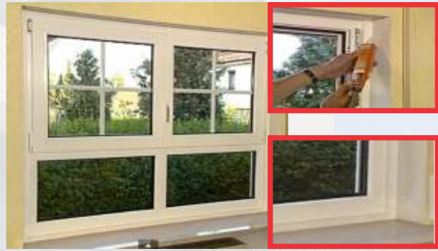
Nach der Montage
