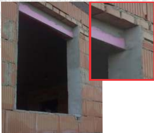
Vorbereitung für Fenstermontage
